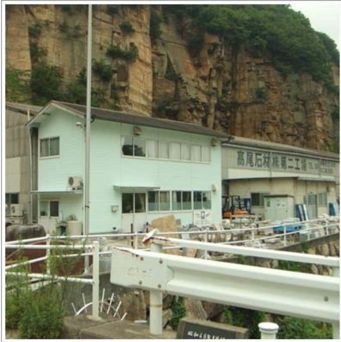
本社石材加工工場
